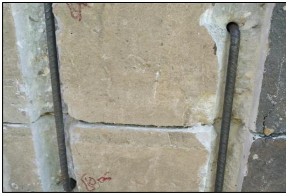
Rebar Stapler Pin Hook များ တပ်ဆင်ထားပုံ
