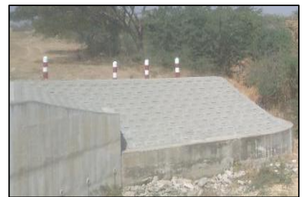
Toe wall လုပ်ငန်း ဆောင်ရွက်ပြီးစီးပုံ
