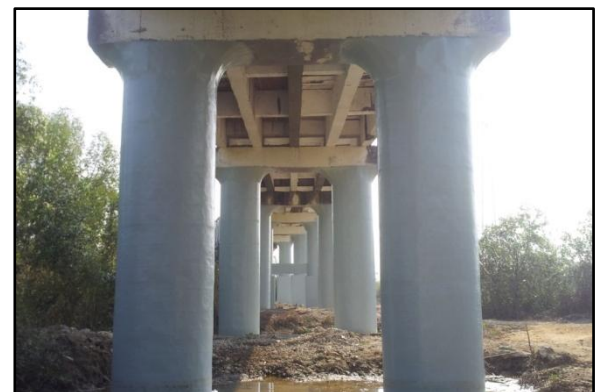
Injection Method ဖြင့် ပြုပြင်ဆောင်ရွက်ထားရှိပုံ
